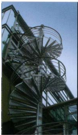
IHK, Karlsruhe: Fluchttreppe
