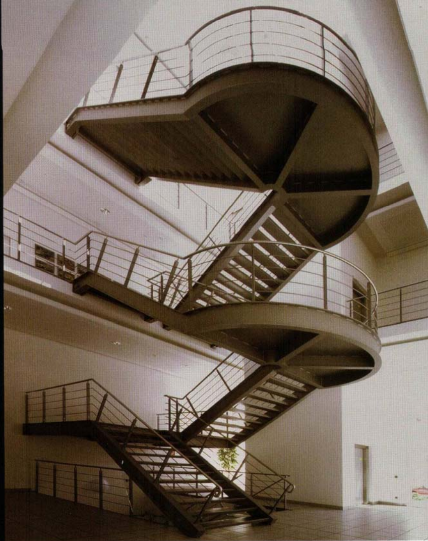
INA-FAG-Gruppe, Herzogenaurach: Freitragende Treppe im Galerie- und Seminargebäude
